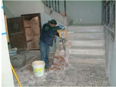
002 Desmuntatge del primer tram .JPG
